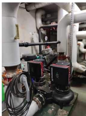
Circulateur primaire de la sous-station
