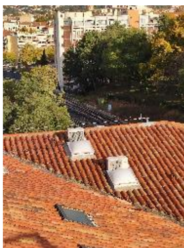
Unités extérieures placés en toiture
