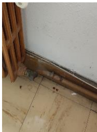
Réseaux de distribution « radiateurs » non calorifugés avec corrosion
