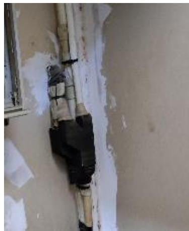
Raccord de dérivation vétuste en intérieur
