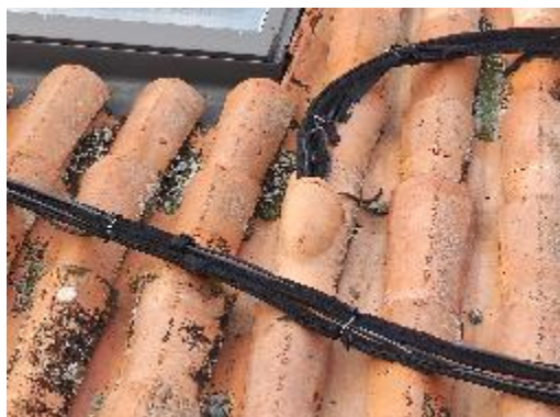
Réseaux frigorifiques dégradés en toiture
